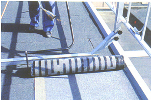
Die Stützelemente lassen sich leicht seitlich verschieben
