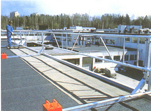
Die große Spannweite von 5,1 m gewährleistet viel Arbeitsraum.
